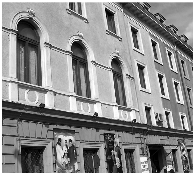
A bukaresti Zsidó Színház épülete
